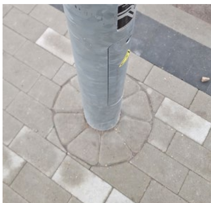
pav. 7 Betoninių trinkelų 200x100 mm klojimo šablonas takuose aplink stulpus bei šulinių liukus
